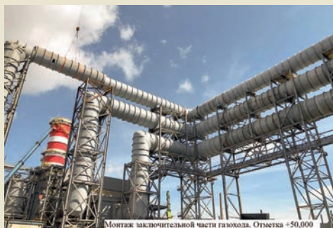
Монтаж заключительной части газохода. Отметка +50,000
