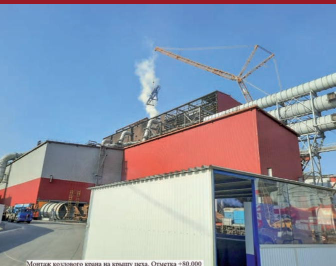
Монтаж козлового крана на крышу цеха. Отметка +80,000
